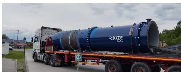
Fot. 1 Transport rurociągu do EW Niedzica
