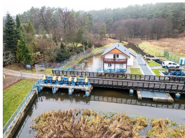
Rys.3 Prace montażowe hydrozespołu UHE 500 w elektrowni oraz nowy budynek elektrowni, widziany od wody górnej
