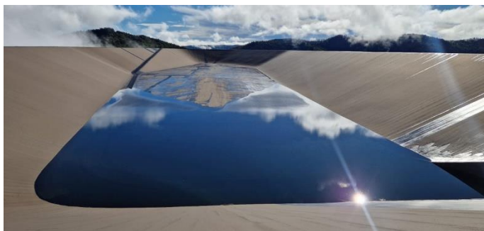
Fot.7 Zbiornik górny EW Porąbka-Żar po modernizacji, prezentacja A.Chyca
