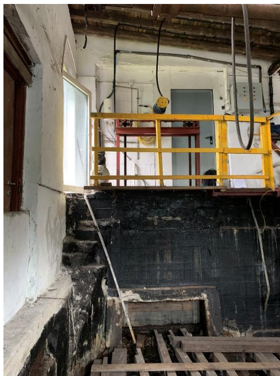
Rys.1 Widok hali maszyn przed modernizacją
