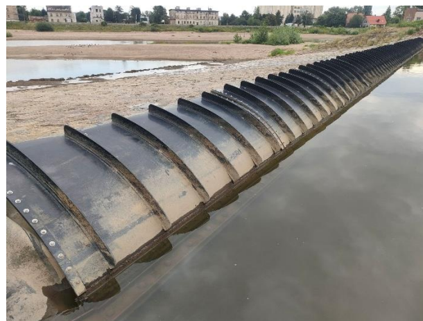
Fot.3.Kompozytowy jaz klapowy z siłownikiem pneumatycznym. Stopień wodny Brzeg rz. Odra (AQUA-Tech 2022)
