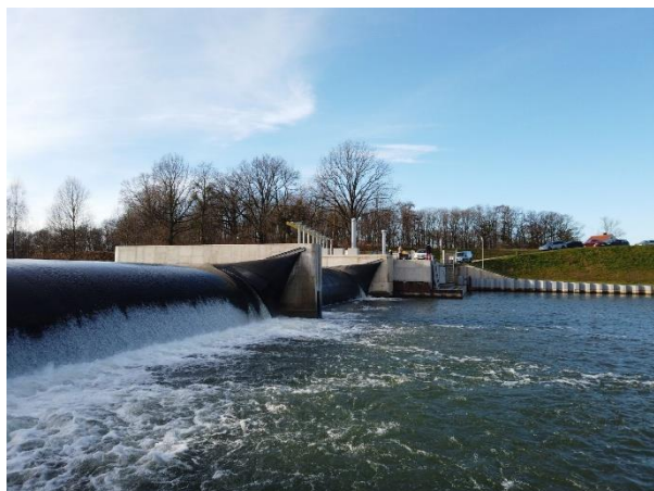
Fot.1. Jaz powłokowy MEW Kopice rz. Nysa Kłodzka wspierający odbudowę torfowisk (AQUA-Tech 2021)
