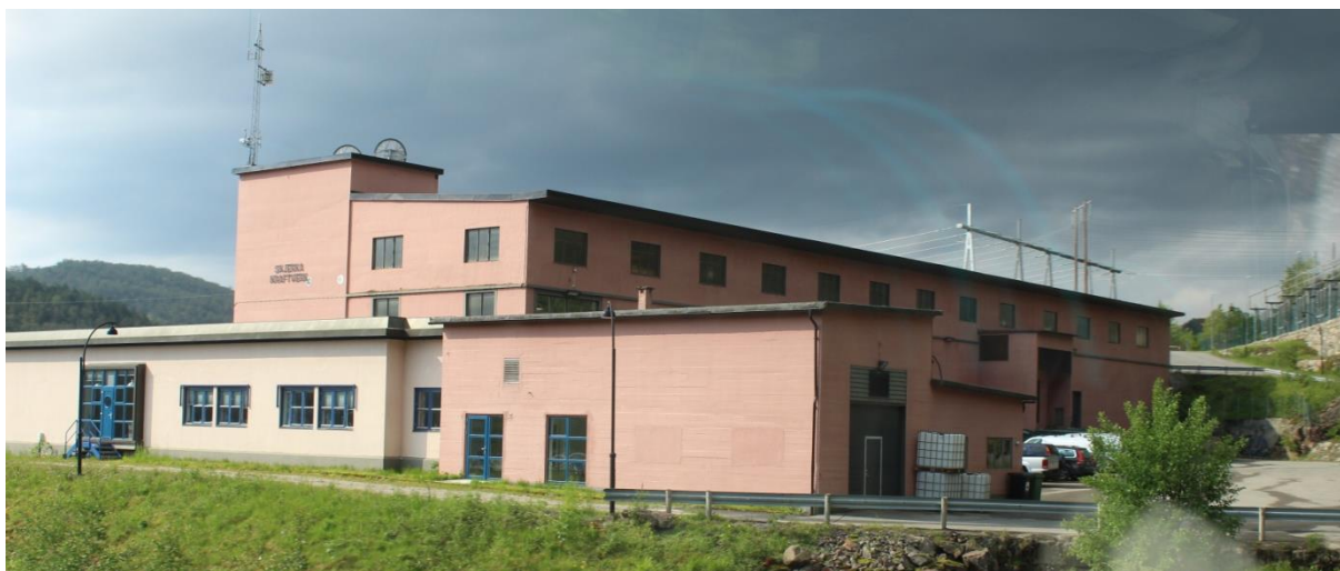
Dotychczasowy budynek EW Skjerka
