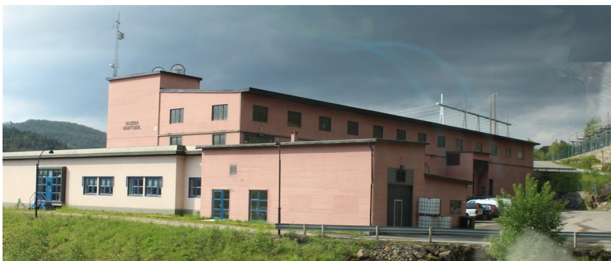
Dotychczasowy budynek EW Skjerka
