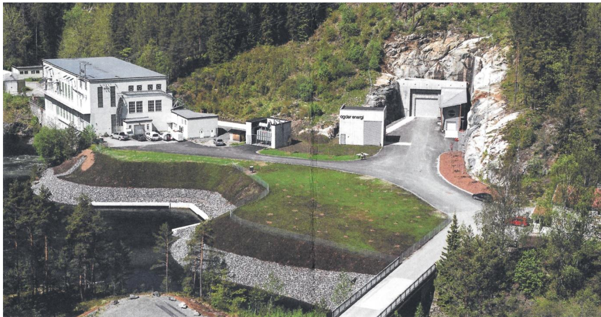
Elektrownie wodne Iveland 1 i 2 położone są na lewym brzegu Otry (źródło: Agder Energi)
