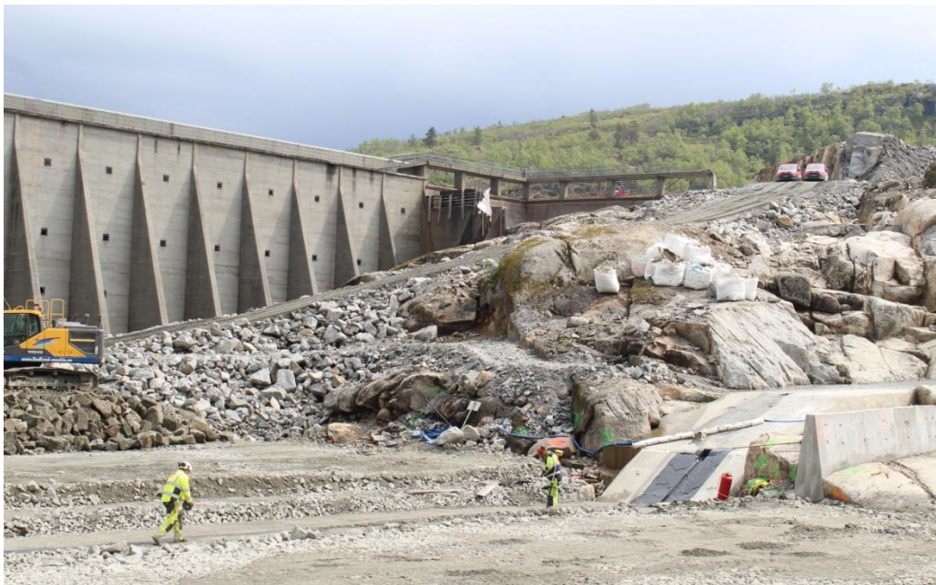
Prace budowlane przy rdzeniu asfaltowym nowej zapory Langevatn
