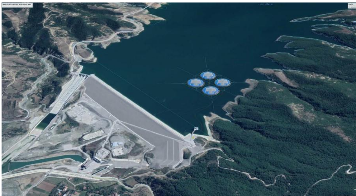
Rośnie zainteresowanie elektrowniami hybrydowymi z pływającymi farmami fotowoltaicznymi. EW Banja w Albanii (73 MW+ 4x0,5 MW, Statkraft). Z prezentacji p. A.Lushnjariego
