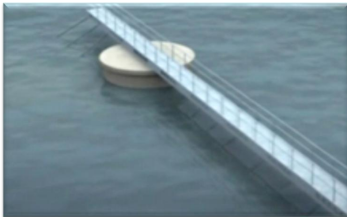
Oczyszczalnia ścieków Płaszów II
