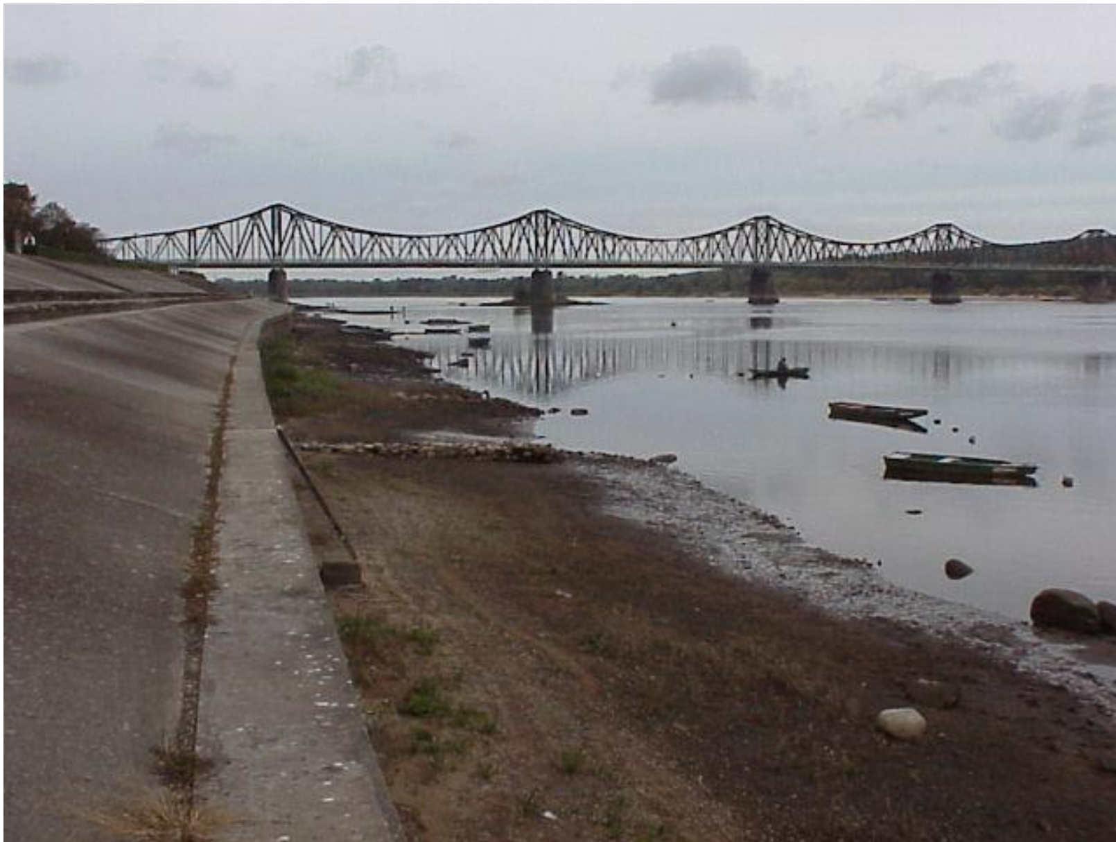
Włocławek – skutki obniżenia lustra wody w Wiśle (normalny stan wody)
