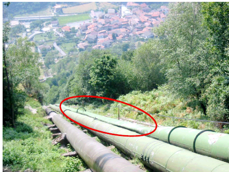
Typowy problem: Skutki dodatniego i ujemnego uderzenia hydraulicznego (Nino Frosio)
