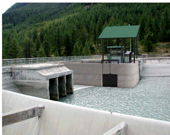
Wyżej: typowy problem - osadzanie się rumowiska. Niżej: środki zaradcze polegające na zmianie konstrukcji urządzeń płuczących (Nino Frosio)
