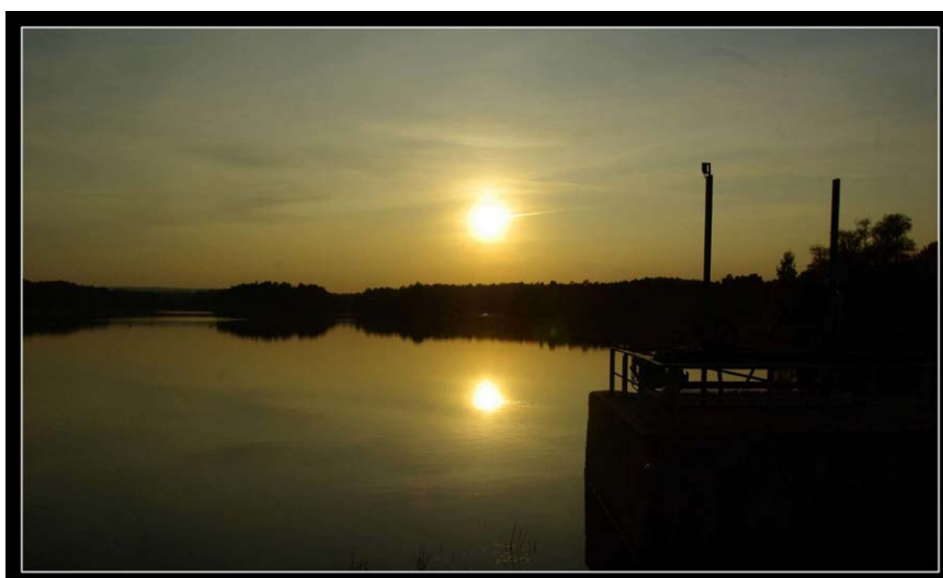
Popołudniowe impresje z Elektrowni Wodnej Straszyn
