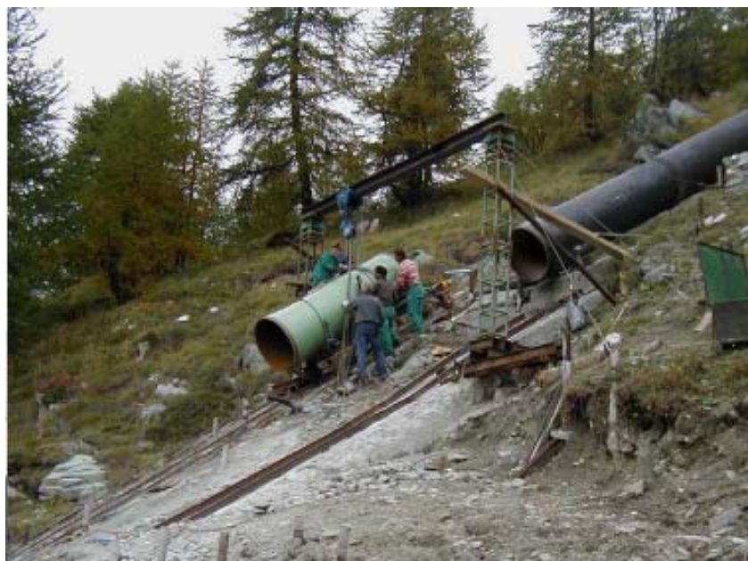
Usuwanie przyczyn awarii rurociągów derywacyjnych poprzez rekonstrukcję i zmniejszanie naprężeń lokalnych (Nino Frosio)
