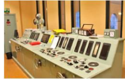
Fot. EW Nomeland: Pulpit sterowniczy w nastawni
